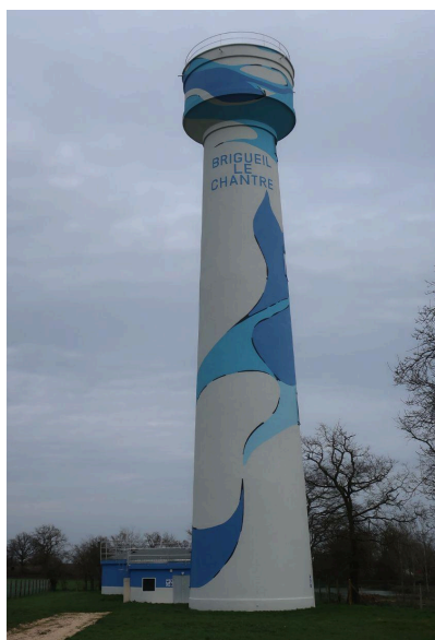
Le château d'eau de Brigueil le Chantre
