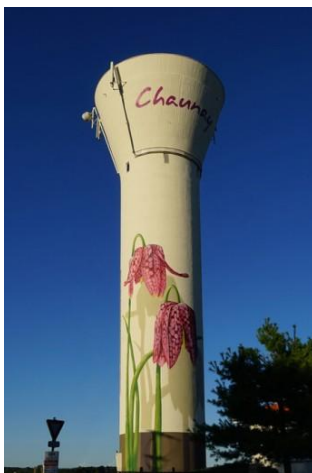
Le château d'eau de Chaunay
