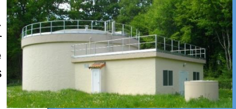
Réservoir de Saint Secondin
