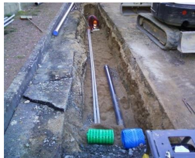
Extension du réseau d'eau potable.
