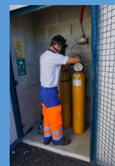
Changement de bouteilles de chlore
