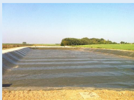
Pose d'une nouvelle géomembrane.
