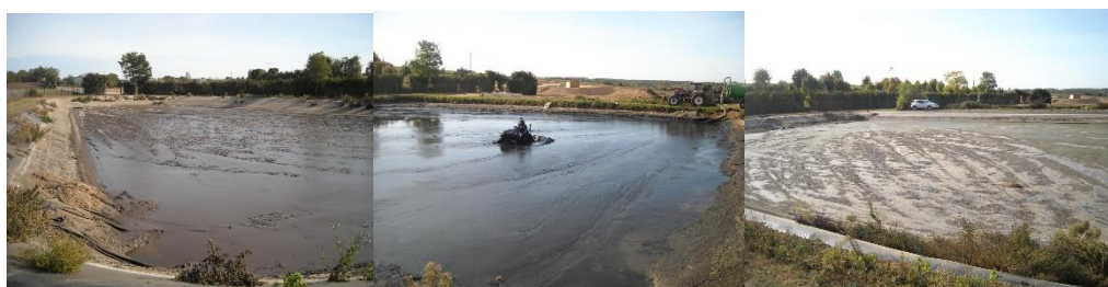
Curage d'une lagune
