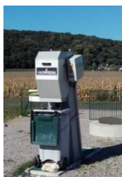
Dégrilleur – Station d'épuration FPR de Buxeuil
