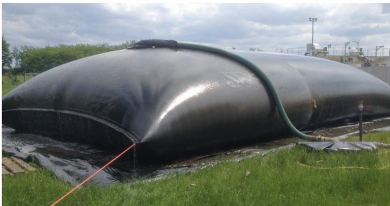
Déshydratation : poche poreuse qui permet de séparer la fraction liquide de la fraction solide des boues. Au bout de quelques mois, obtention de boues qui ont la structure d'un terreau.
