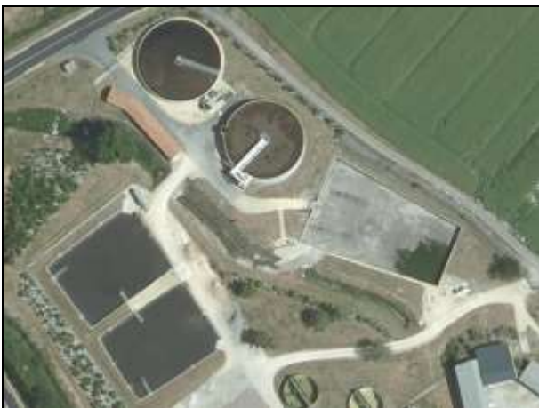
Photo 2 : Vue générale de la station
