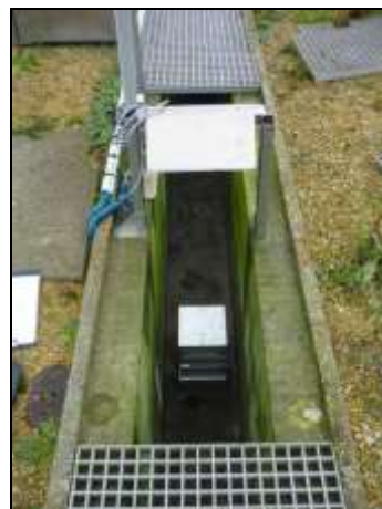
Photo 5 : Canal de sortie
