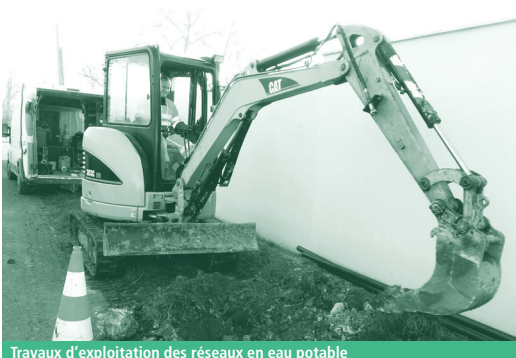
Travaux d'exploitation des réseaux en eau potable
